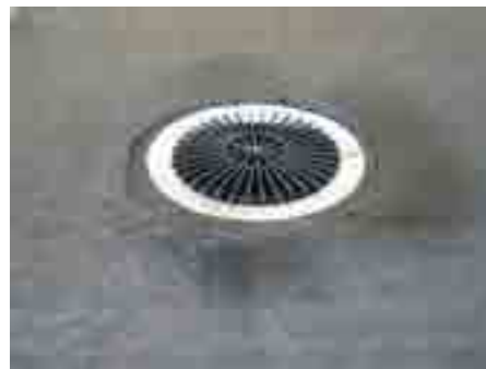
5. Fachgerechte Einbindung des Ablaufs in zweilagige Bitumenabdichtung
