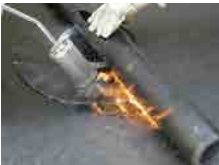
4. Zweite Bitumenlage mit Bitumenkragen des Ablaufs verbinden
